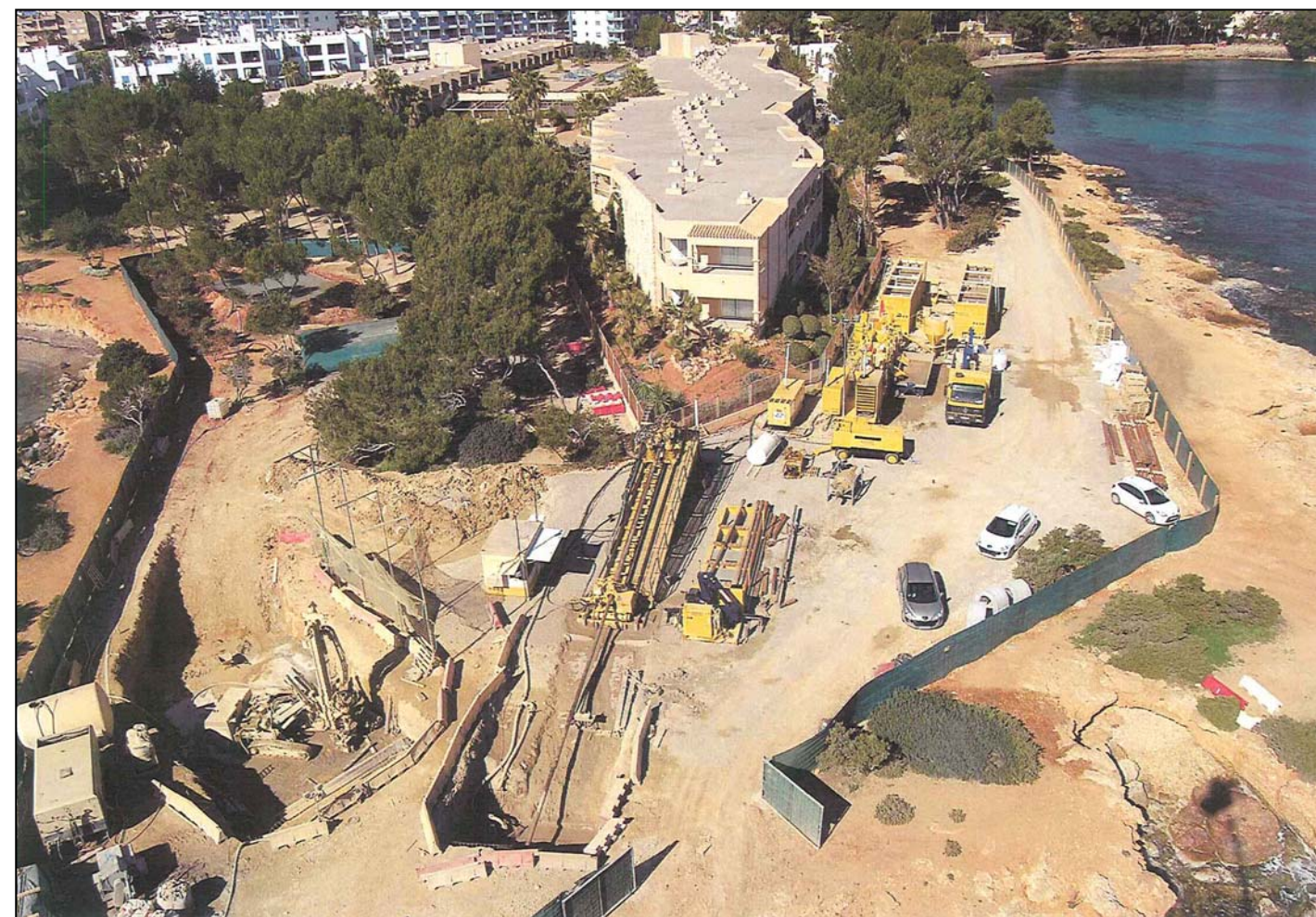
Fotografia emplaçament de perforació per la construcció d'una perforació terra-mar (approach)
