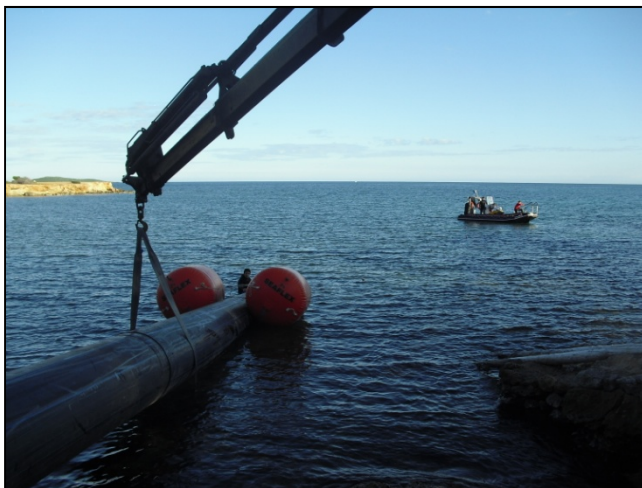
Maniobres de llançament del tub al mar
