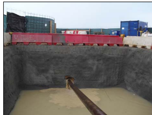
Fotografies de la cata d'entrada i detall del bit de perforació abans de començar a perforar
